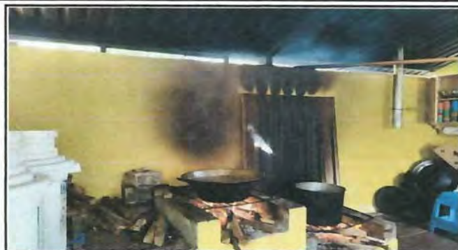
Foto 14: Se instalará asulejo a las estufa rurales, se reconstruirá la que está baja y se instalará una chimenea.
