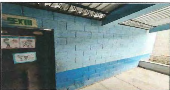
Foto 11: Se aumentará la altura de aulas ya existentes, agregando hiladas de block.
