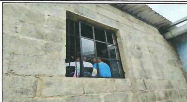
Foto 2: Se repararán las ventanas para que se puedan abrir, se instalarán algunas nuevas y se instalarán balcones de metal.
