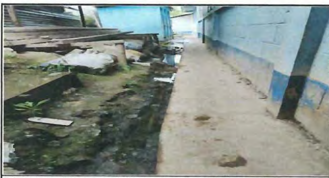
Foto 5: Se instalará cuneta de concreto con parrilla de metal
