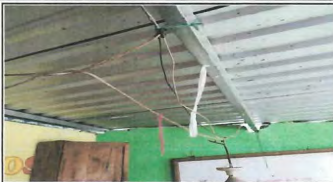
Foto 13: Se cambiará toda la red eléctrica de la escuela.
