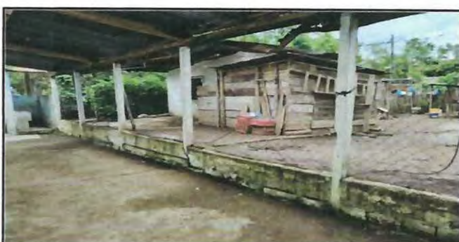
Foto 12: Se reparará parte del muro perimetral, con muro de block y columnas.
