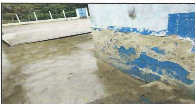
Foto 15: Se necesit aplicación de repello, cernido o alisado.
