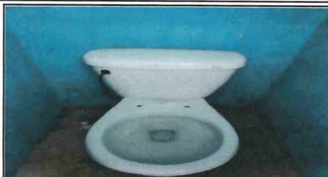
Foto 8: Se instalará azulejo en las paredes y piso de los sanitarios.
