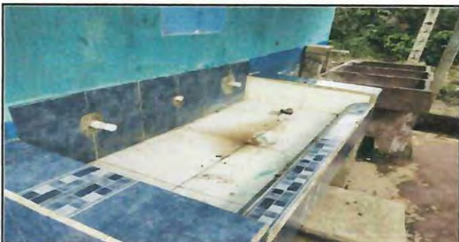
Foto 9: Se instalarán llaves de chorro en lavamanos y pilas
